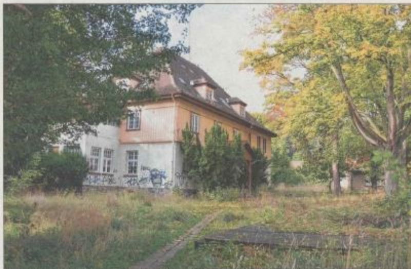
Das Areal der ehemaligen Kindertagesstätte „Villa Sonnenschein“ in unmittelbarer Nähe des Forellenteichs mit Parkanlage in Ilsenburg ist alles andere als ein „Sonnenschein“. Ideen für eine Wohnbebauung gibt es. Foto: Regina Urbat
